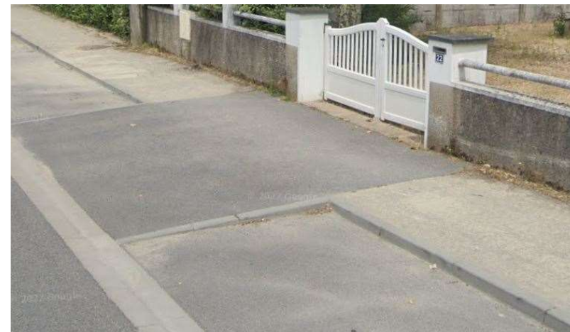
Sable ciment sur trottoir et enrobé noir sur accès
